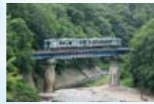
▲ JR小海線ハイレールJRで最も高い場所を走る小海線、その最高地点は1375m。小海線の駅入線後、ハイレール1375は2017年の開通時から人気です。
